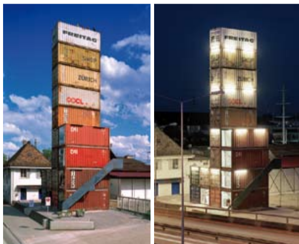
Sonderpreis für den Freitag Flagship Store in Zürich: Die ersten 4 Etagen sind Verkaufsräume.
